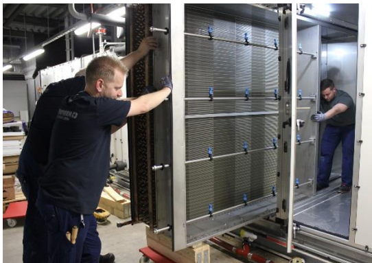
Einbau der neuen Register
