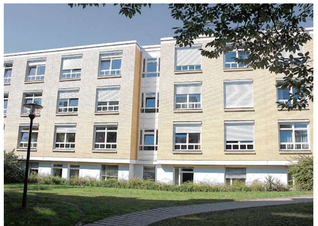
Das Bettenhaus der Psychiatrie: Auf drei Etagen befinden sich die Pflegestationen 41, 42, und 43.
