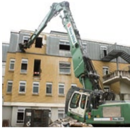
Der erste Baggerbiss am Erweiterungsbau erfolgte Mitte September.
