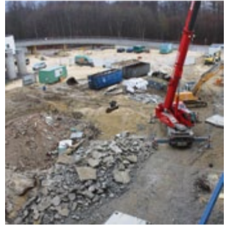
Ende November waren noch die Kellerwände zu sehen, ebenso war die alte Cafeteria verschwunden und am Funktionsbau wurden große Betonfassadenelemente entfernt.
