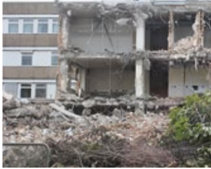
Mitte Oktober war der Erweiterungsbau zu mehr als der Hälfte abgerissen.
