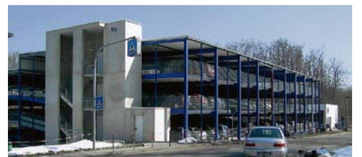
2005 wird das Parkhaus in Betrieb genommen.
