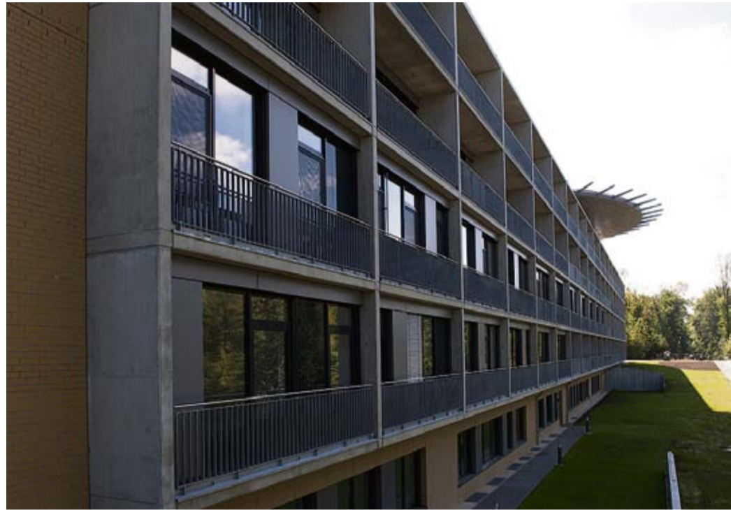
Zu besichtigen am Samstag, 10. November 2012: Das neue Haus C des Klinikums auf dem Schlossberg.
