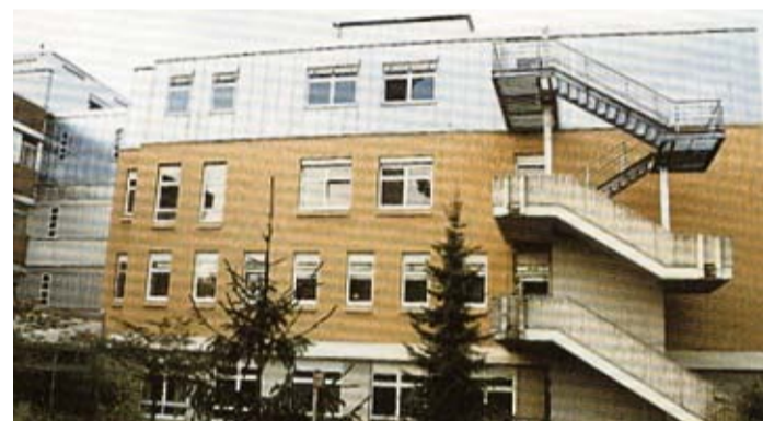
1997 erhielt der 10 Jahre zuvor für 6 Millionen DM fertiggestellte Erweiterungsbau eine weitere Etage aufgesetzt, sie bietet Platz für die Innere Intensivstation.
