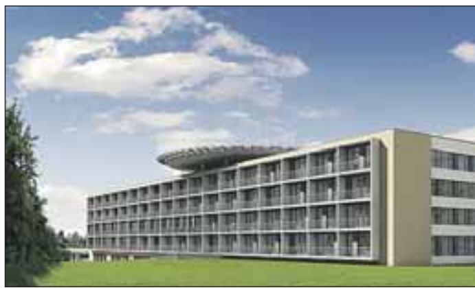
Zukünftig landen und starten Hubschrauber auf dem Dach des neuen rund 110 Meter langen und 30 m breiten sechsgeschossigen Bettenhaus C. Der Durchmesser des Hubschrauberlandeplatzes beträgt 34 Meter.
