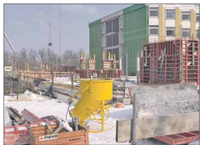
Blick auf die Rohbauarbeiten am Erdgeschoss des zukünftigen Bettenhauses C. Im Hintergrund ist die Stirnseite des Bettenhauses A zu erkennen, an die das neue Bettenhaus angedockt wird.
